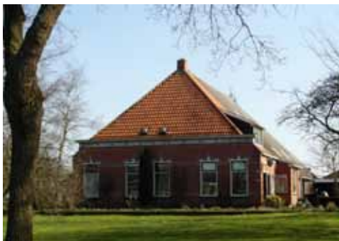
Haarsterweg 40, de situatie van de in 1910/1911 gebouwde boerderij (Foto Geert Braam)
